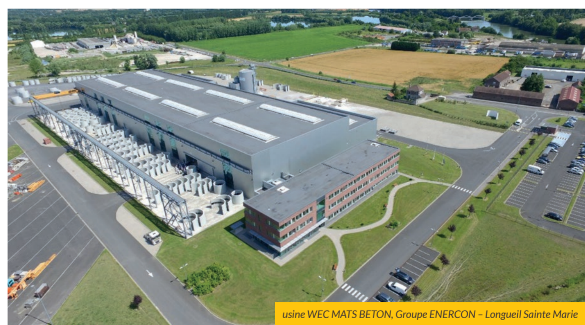
usine WEC MATS BETON, Groupe ENERCON - Longueil Sainte Marie
